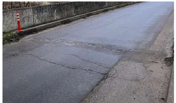
10 pav. Deformacinių pjūvių konstrukcijos įdubusios.
