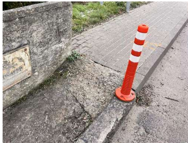
7 pav. Ištrupėję šalitilčio plokštės kraštai, nusidėvėjusi asfalto danga.
