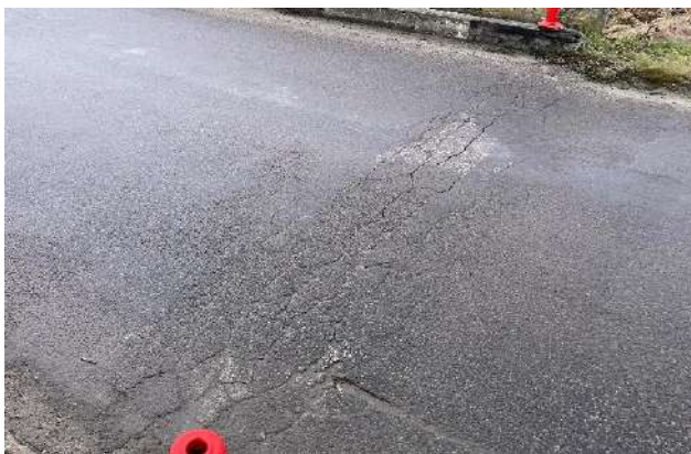
10 pav. Deformacinių pjūvių konstrukcijos įdubusios.
