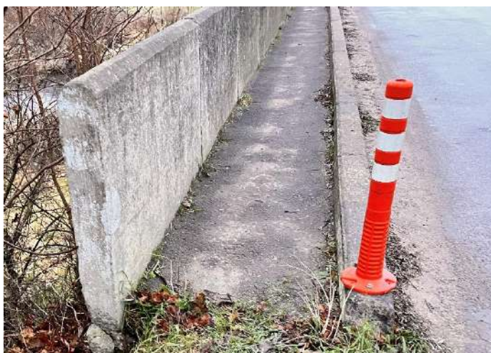
7 pav. Ištrupėję šalitilčio plokštės kraštai, nusidėvėjusi asfalto danga.
