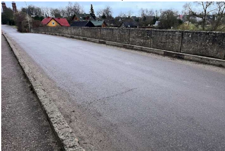
6 pav. Šulinėliai užnešti arba užasfaltuoti.
